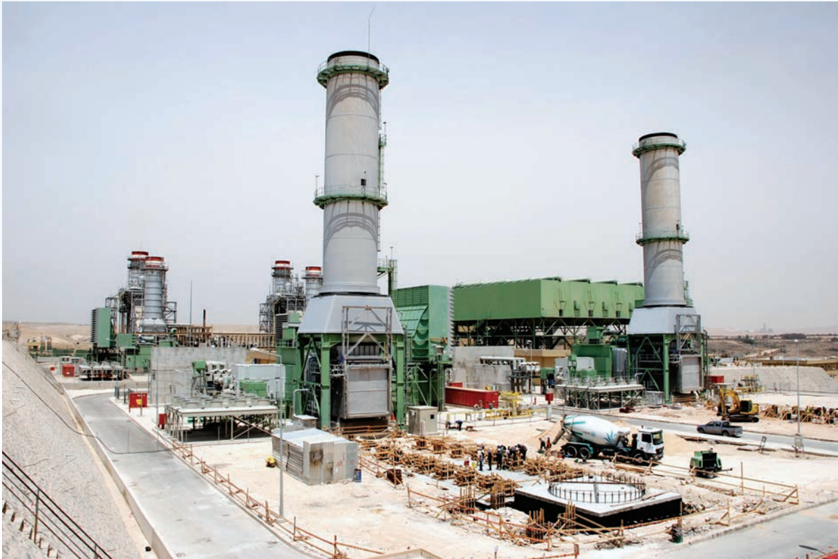
اعمال مشروع التوسعة (اضافة توربين بخاري)- المرحلة الثانية
